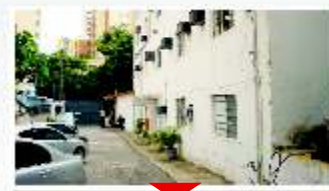
VILA MASCOTE Galpão industrial
